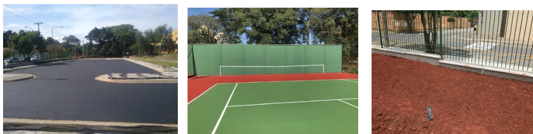
Figura 18 – Reforma de quadras de esporte, do estacionamento e substituição de alambrados por grades
