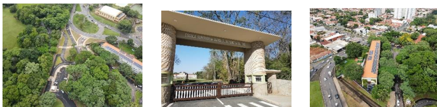
Figura 19 – Remodelação da entrada principal do campus
