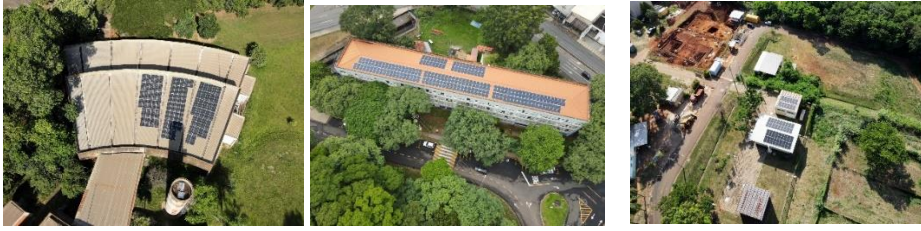
Figura 15 – Instalação de placas fotovoltaicas em 3 edificações
