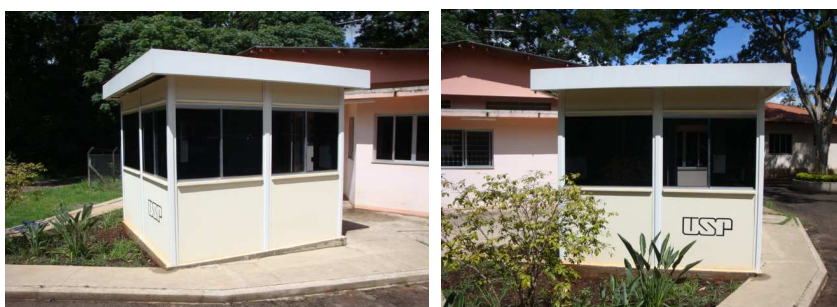
Entrada das Divisões Administrativa e de Manutenção e Operação
