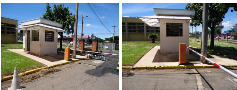
Figura 19 – Colocação de toldo e reforma da calçada na Guarita do CEBTEC
