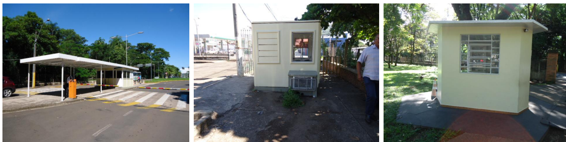
Figura 21 – Portaria Principal, Portaria da Av. Carlos Botelho e Portaria da Engenharia
