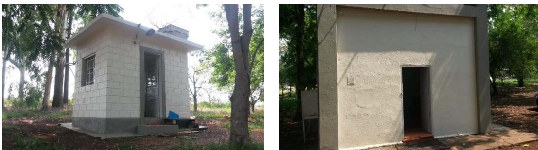
Figura 40 – Pivô Central (FAR) e Colônia da Fazenda Areão (FAR)
