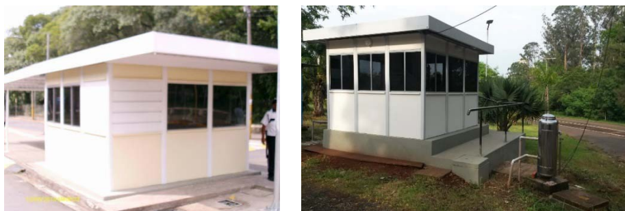
Figura 44 – Portaria Principal e ESALQ LOG
