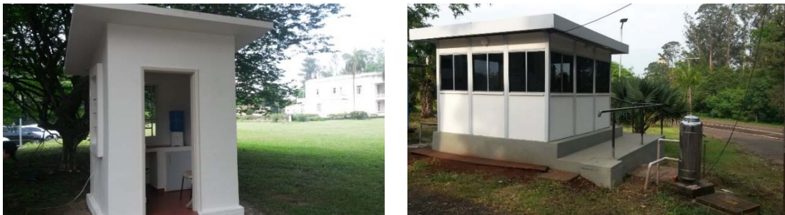
Figura 39 – Fundos do Departamento de Engenharia e ESALQ LOG
