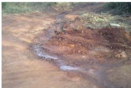
Figura 02 - Contenção de esgoto que corria a céu aberto
