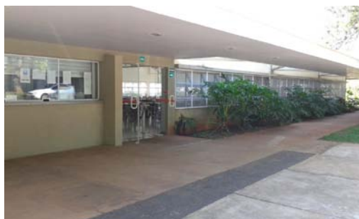
Figura 10 - Fachada do novo Restaurante Universitário
