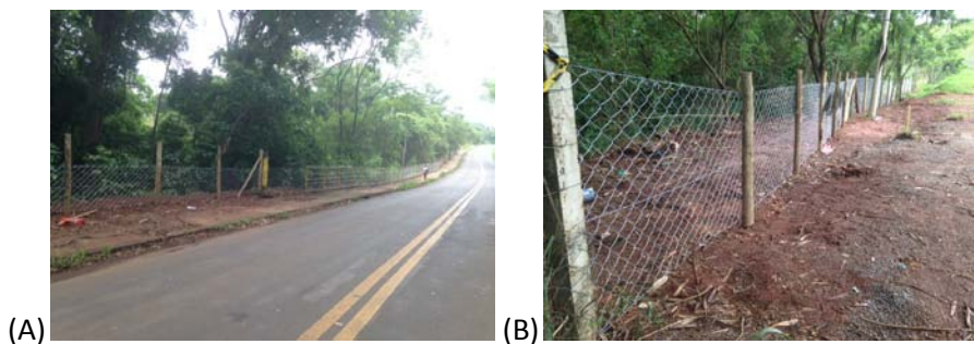
Figura 5- (A) Alambrado nas proximidades do Ribeirão Piracicamirim; (B) Alambrado nas proximidades do viaduto da Rodovia do Açúcar.
