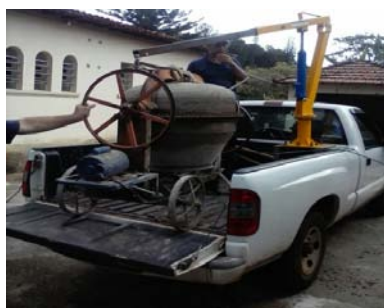
Figura 19 - Aquisição de guincho mecânico para elevação de equipamentos
