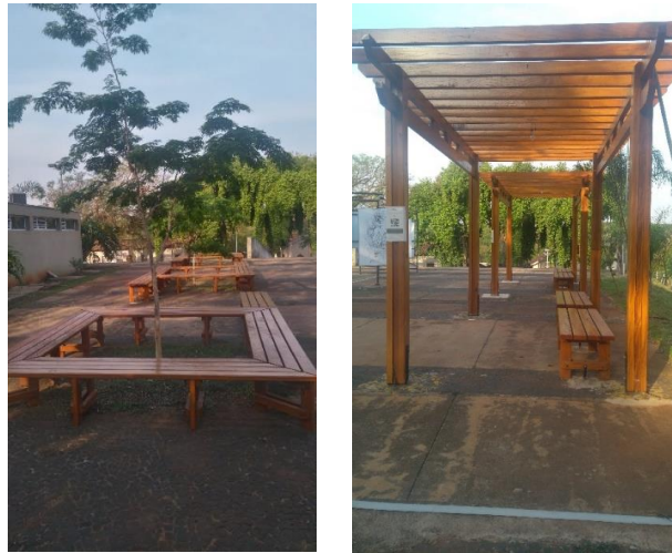
Figura 15: Instalação de bancos e pergolados
