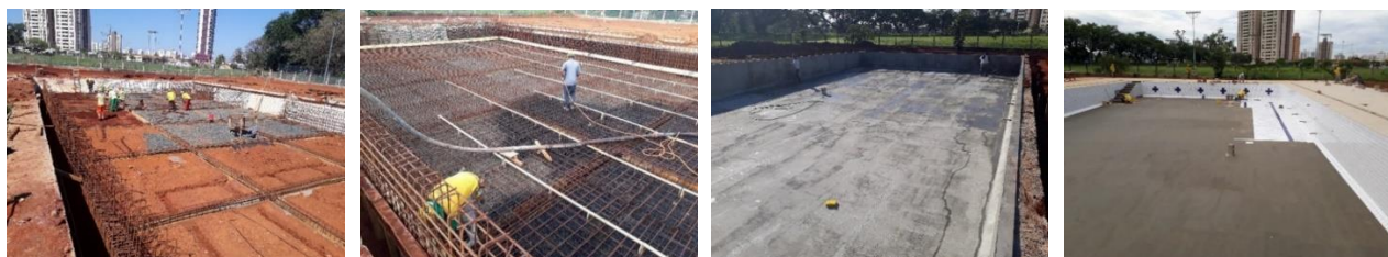
Figura 3: Etapas de reforma da piscina
