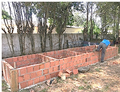
Figura 44: Instalação de nova composteira da creche
