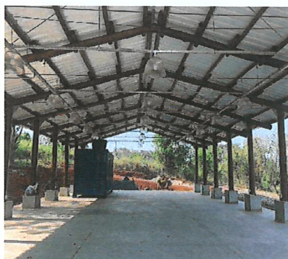
Figura 43 – Central de compostagem da Prefeitura do campus (em instalação).
