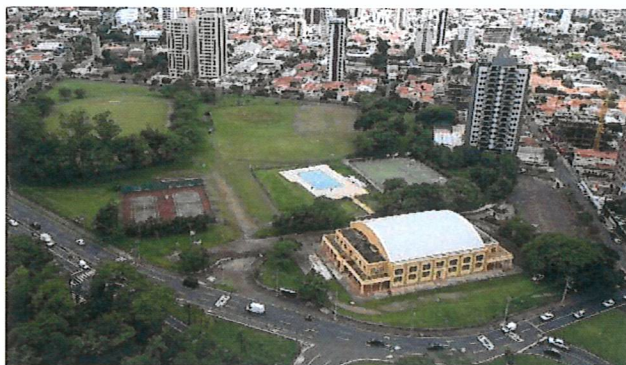
Figura 29 - Instalações da Seção Técnica de Práticas Esportivas.
